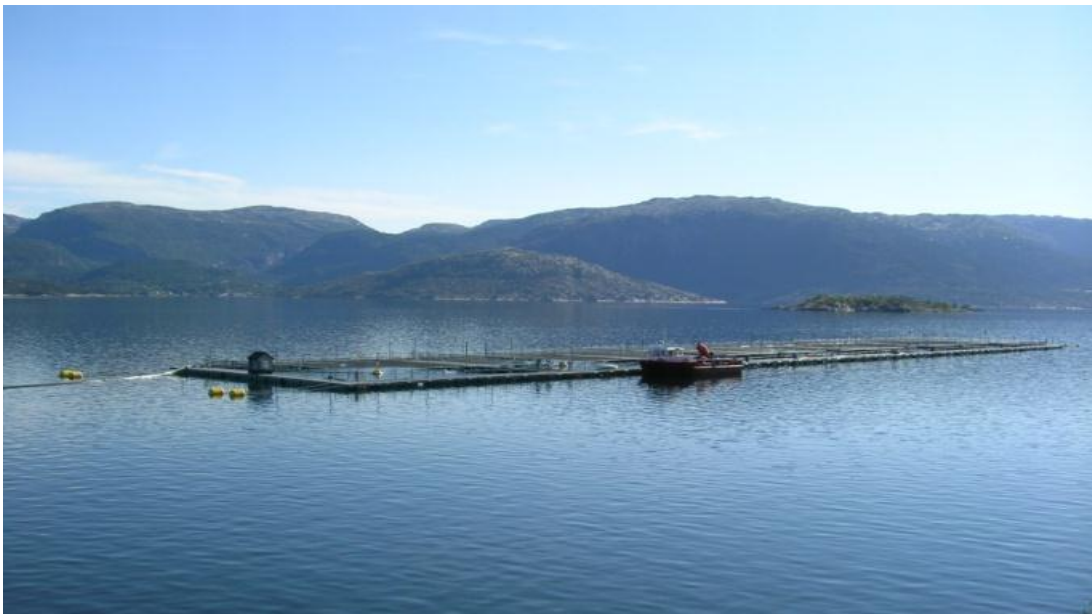
Bilde 4: Moderne stålanlegg i Austfjorden Foto: Christoffer Marøy
