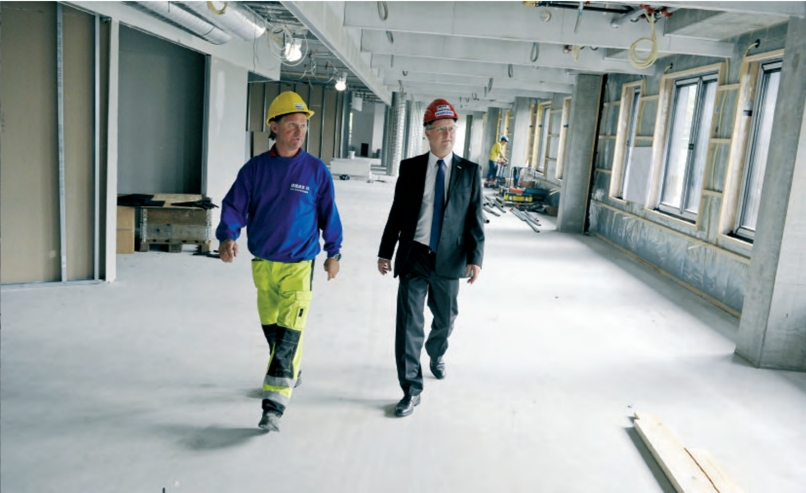
Rune Nilsen og Jan I. Haaland på vei gjennom etasjene i NHHs nye praktbygg. Mye arbeid gjenstår før de over 3 000 studentene kan ta bygget i bruk, men Nilsen garanterer at bygget skal stå ferdig til april.
