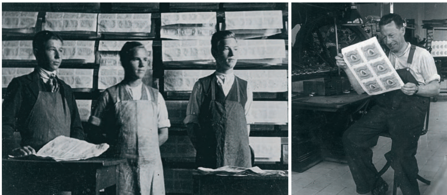
NORGES BANKS SEDDELTRYKKERI, 1930. ARBEID MED KOBBERTRYKK PÅ VÅTT PAPIR. SEDLENE MÅTTE HENGES TIL TØRK.
