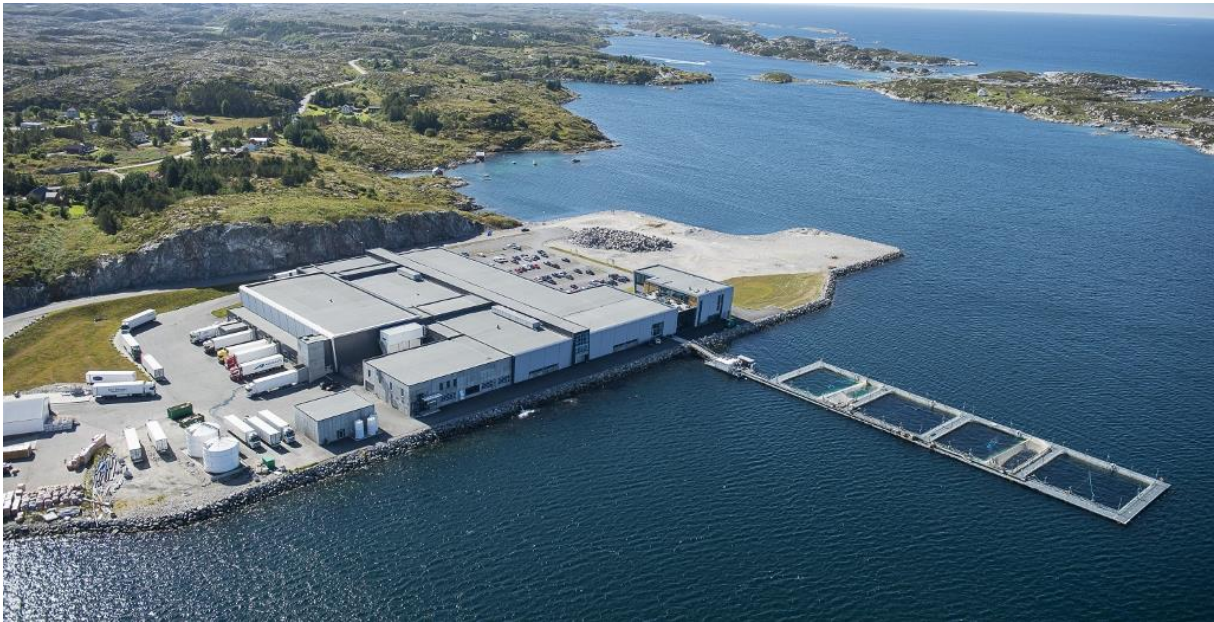
Bilde 5-1: Produksjonsanlegget InnovaMar på Frøya (SalMar, 2014g)
